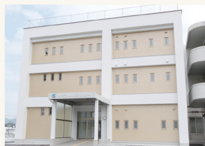
10 南さつま市防災センター
